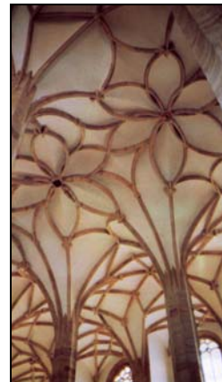
Gewölbe im Mittelschiff
